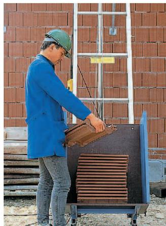
plateau universel avec protections latérales pliables
